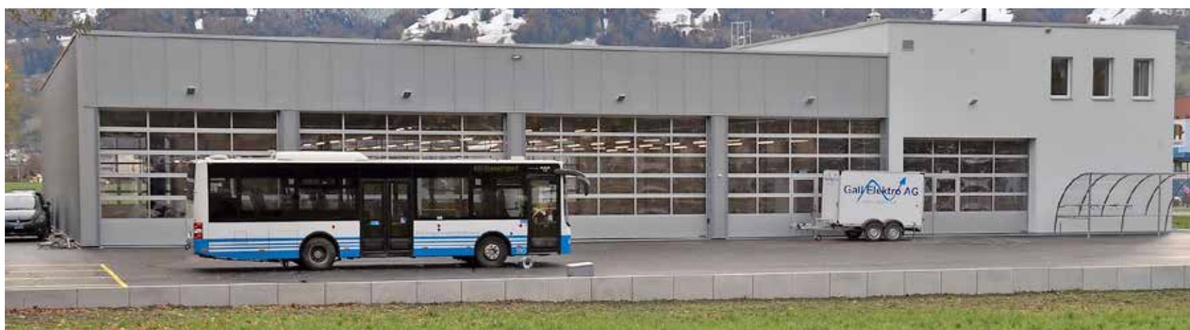
Die neue «Heimat» der Fahrzeugflotte von Bus Sarganserland Werdenberg: Das Busdepot im Sarganser Tiefriet ist fertig erstellt.
